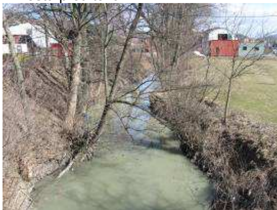
z mostu proti toku
