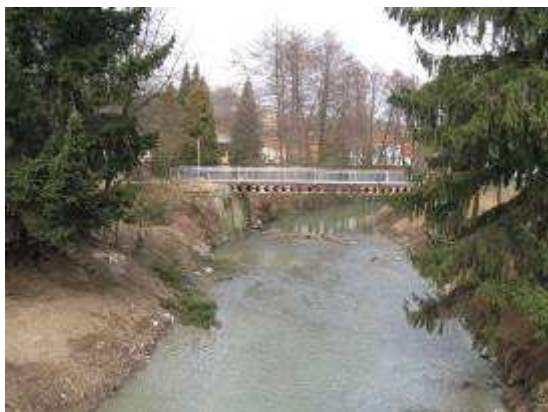
Lávka km 5,296 (TPE 5,220) Pohled proti toku.
