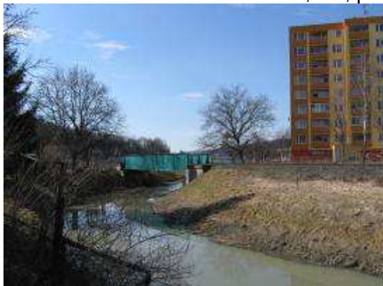
Pohled na železniční most km 10,586, po toku
