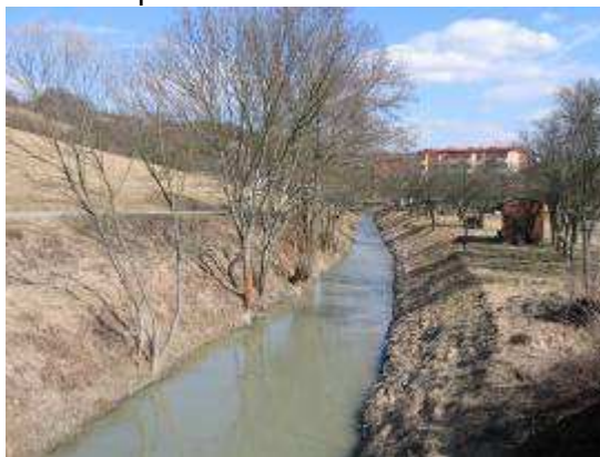
z mostu proti toku
