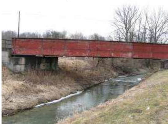
Železniční most po toku
