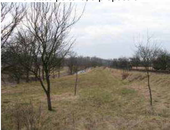
po toku na PB směrem k žel. mostu
