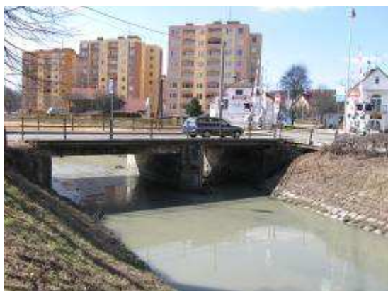
Po toku z mostu, práh km 10,710
