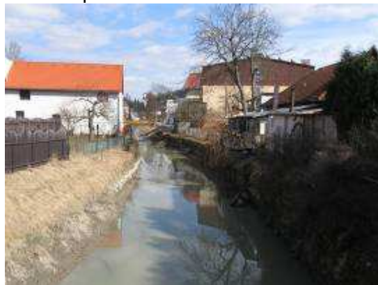
z mostu proti toku
