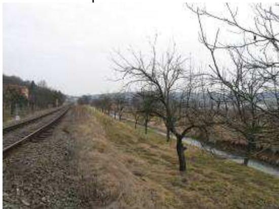
Propustek v železnici, DN300, PB
