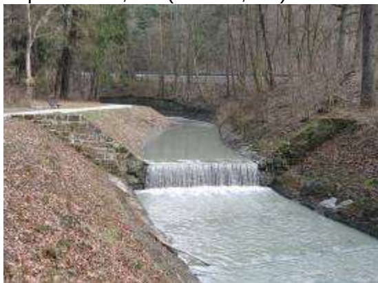
LB propustek –neměřen, DN 1000
