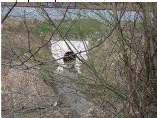
PB propustek pod železnicí, DN800
