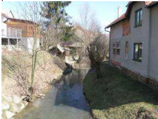
proti toku z mostu
