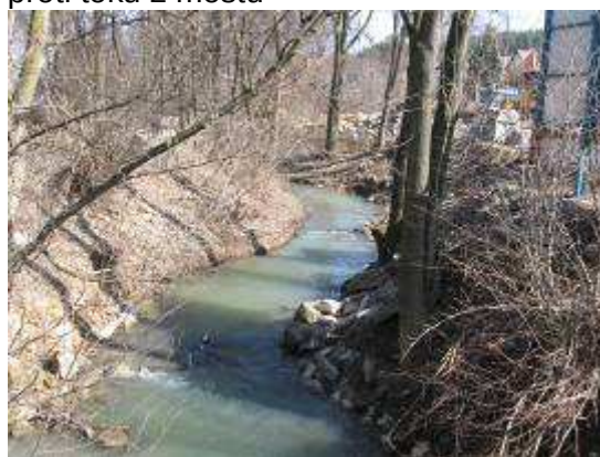
proti toku z mostu
