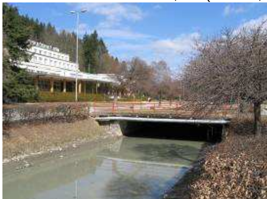
začátek zatrubnění km 12,509 (TPE 12,430)
