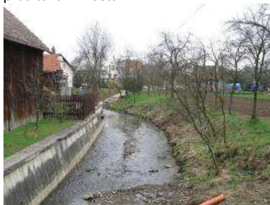
proti toku z mostu
