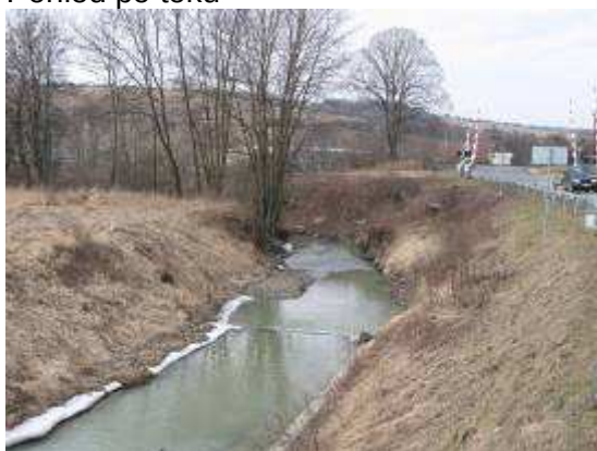
Pohled proti toku z mostu
