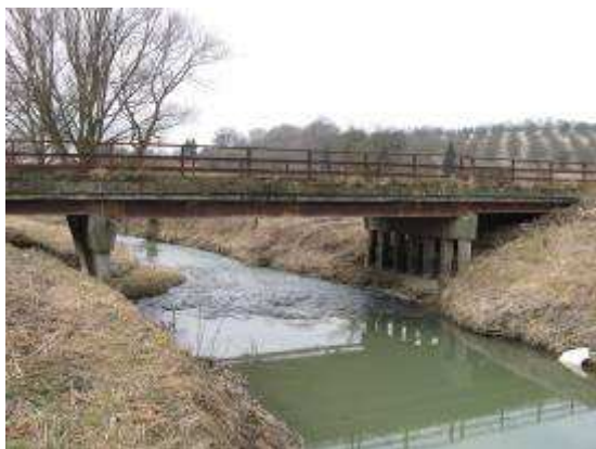
Pohled z mostu po toku
