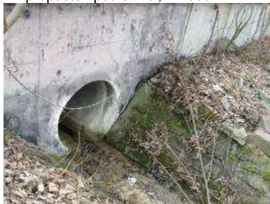
LB propustek pod silnicí, DN600
