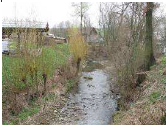
propustek na PB-Hájový p. km 21,961
