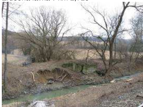
Zrušená lávka v km 2,715
