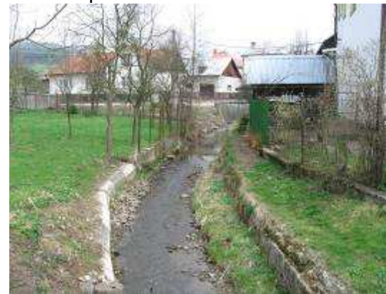
z mostu proti toku
